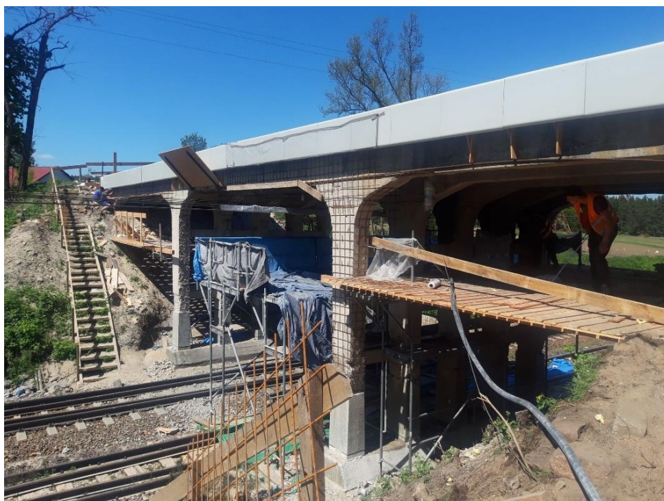
Remont wiaduktu w miejscowości Gumnisko
