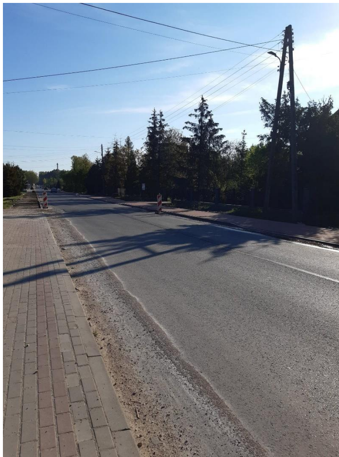
Przebudowa i rozbudowa drogi nr 3500E na odcinku Pajęczno - Biała
