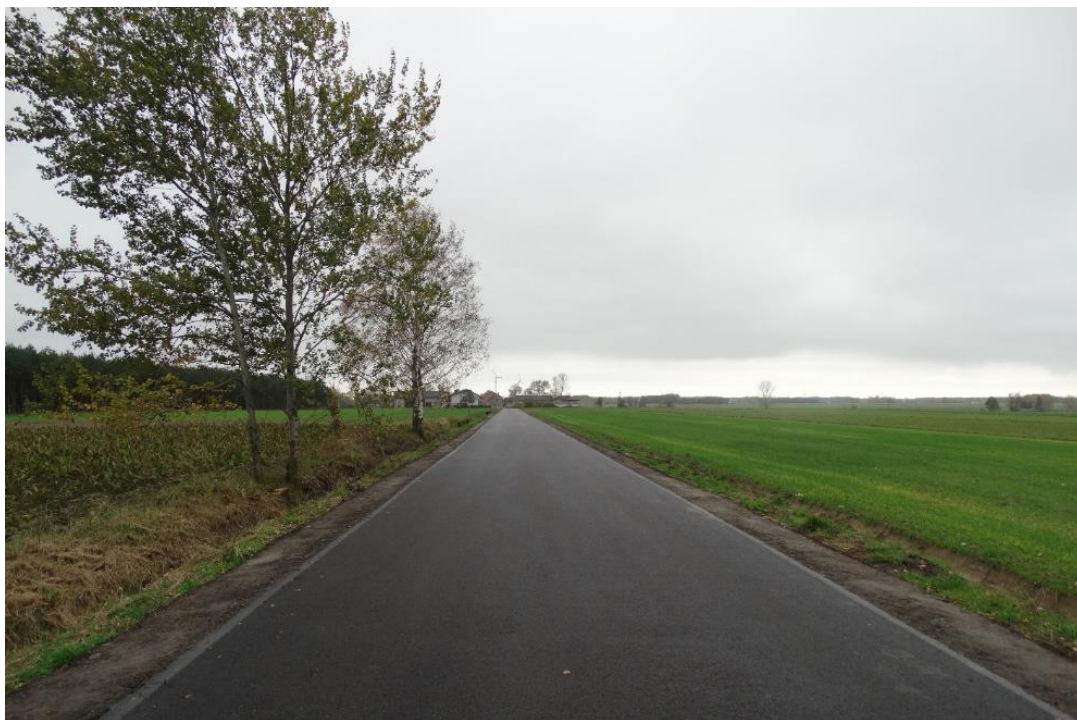
Droga powiatowa nr 4526E w m. Kiełczygłówek.
