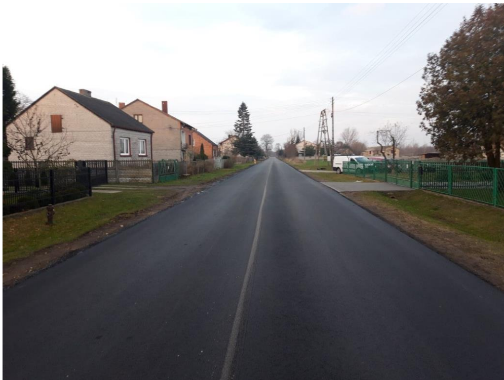
Droga nr 3515 E w Zamościu Kolonia
